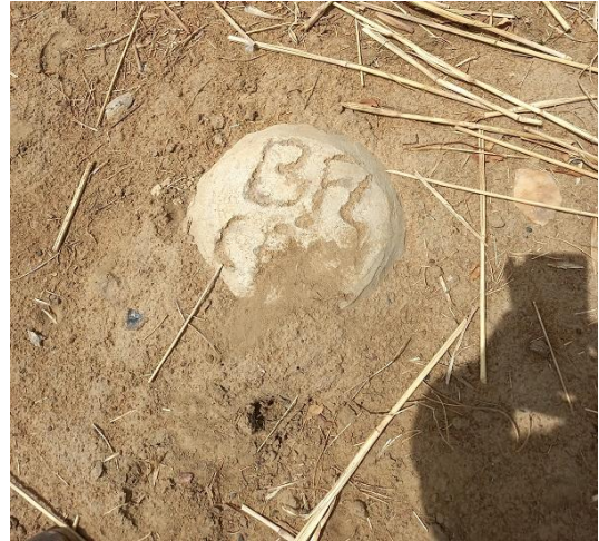
Photo 2 : matérialisation des sites des bornes fontaines
