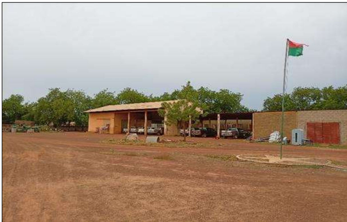
Photo N° 5 : Vu du terrain pour la réhabilitation du garage Source : données terrain BEEDD ; Juillet 2025
