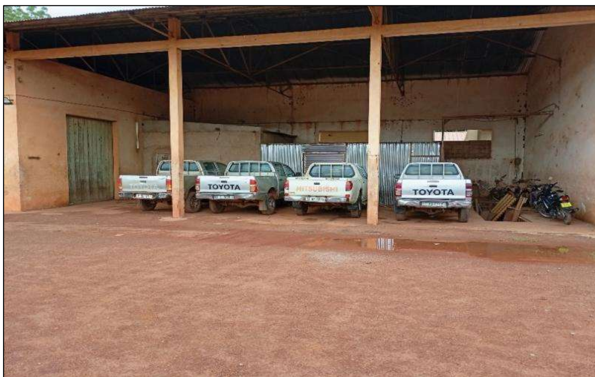
Photo N° 6 : vu du terrain à aménager pour la réhabilitation du garage Source : données terrain BEEDD ; Juillet 2025
