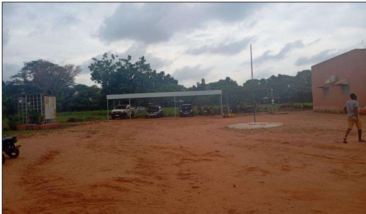
Photo n° 5 : Vu du terrain pour la construction du garage
