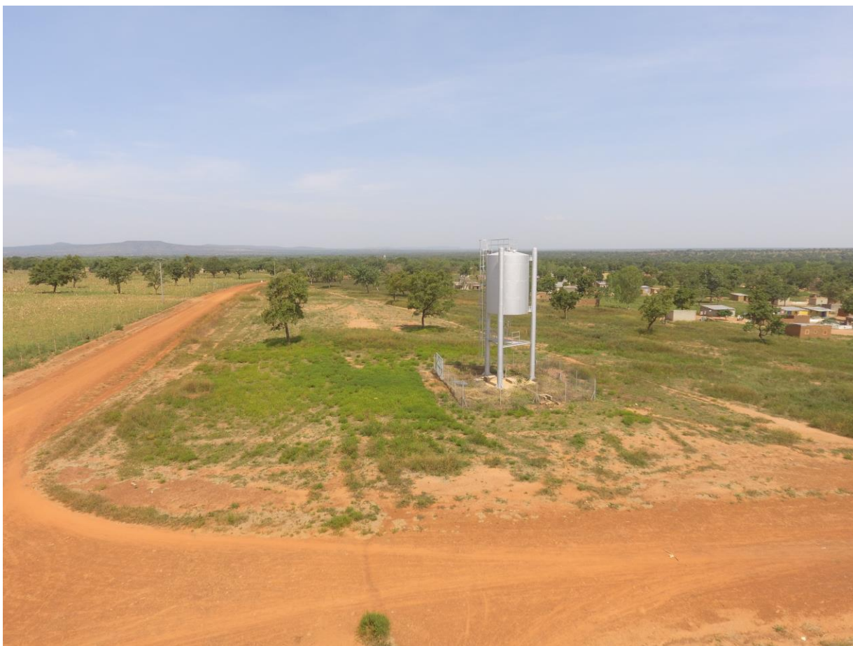
Photo 6: Château d'eau de l'AEPS du site d'accueil de Soungalodaga 3
