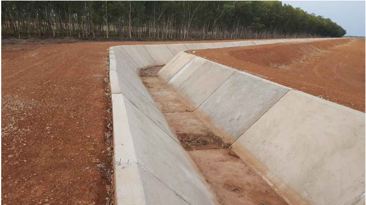
Photo 4 : Canal primaire CP1 du périmètre irrigué de Niéguéma/Toukoro
