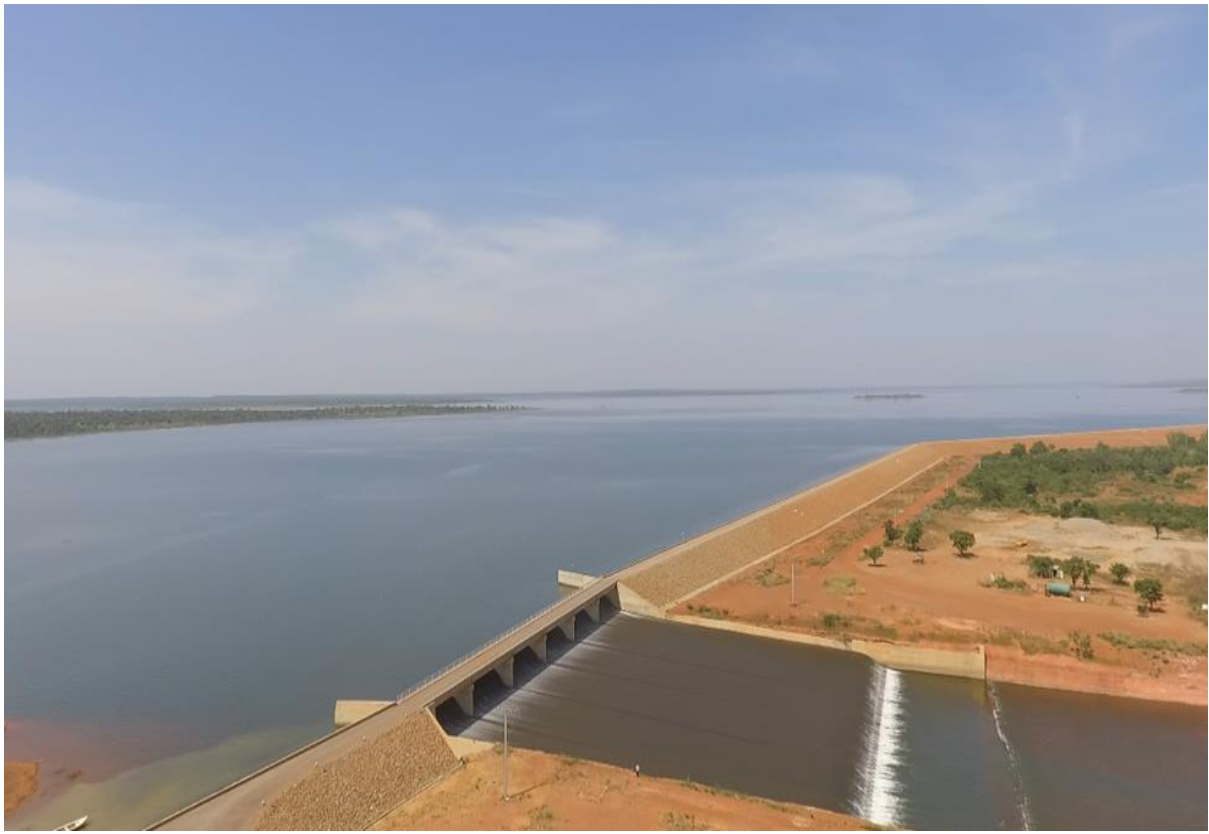
Photo 2 : Vue du déversoir et de la digue du barrage de Samendéni
