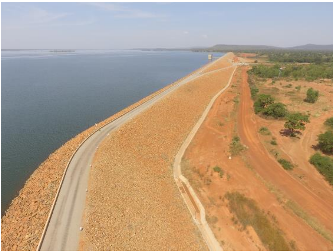
Photo 1 : Vue de la digue du barrage de Samendéni
