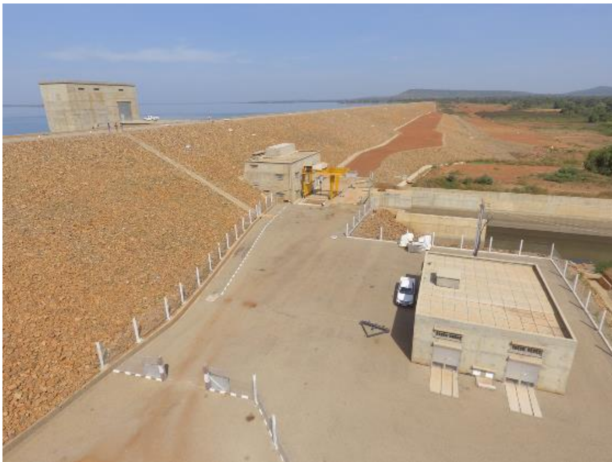
Photo 3 : Vue la plateforme de la centrale hydroélectrique du barrage de Samendéni
