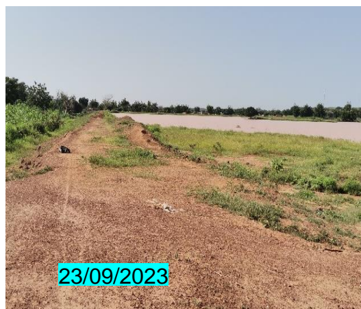
Photo 4 : digue actuelle du barrage
