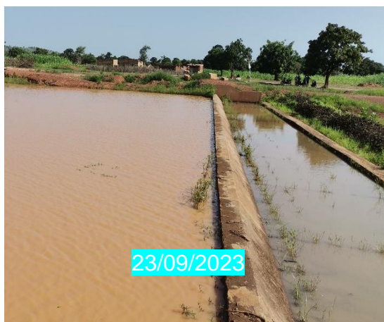
Photo 1 : déversoir actuel du barrage
