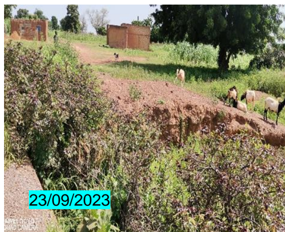
Photo 3 : présence d'animaux domestiques dans les abords du barrage
